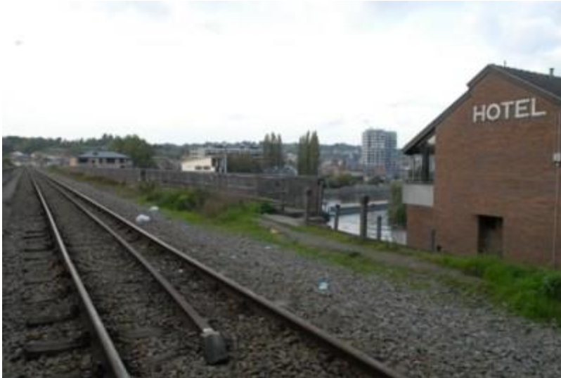
Un RAVeL sur le pont de Fer?
